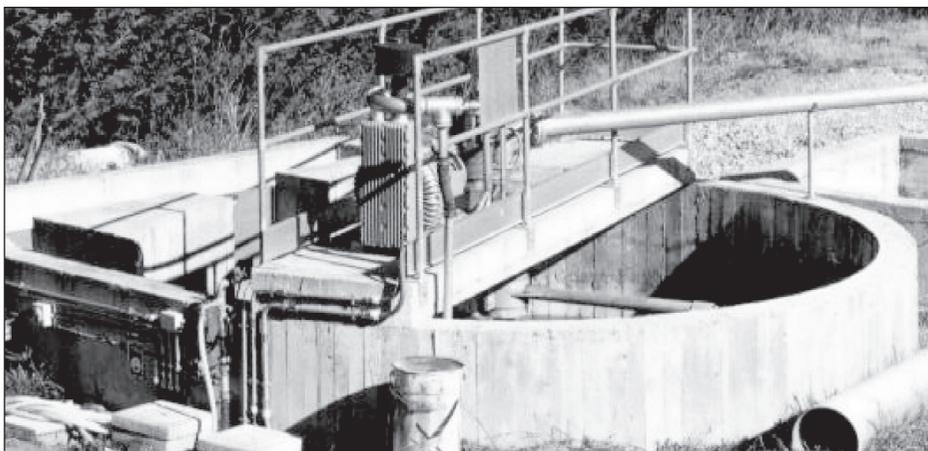
**Figura 3.16** – Dissabbiatore circolare a pale (mod. DFO): particolari. Foto Ecoplants S.r.l.
