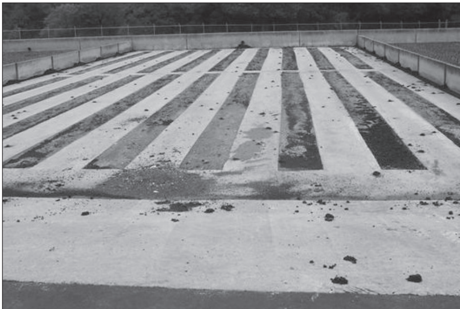
Figura 10.1 – Preparazione di un'area di terreno per l'essiccamento naturale del fango. Letti di essiccamento vuoti.
