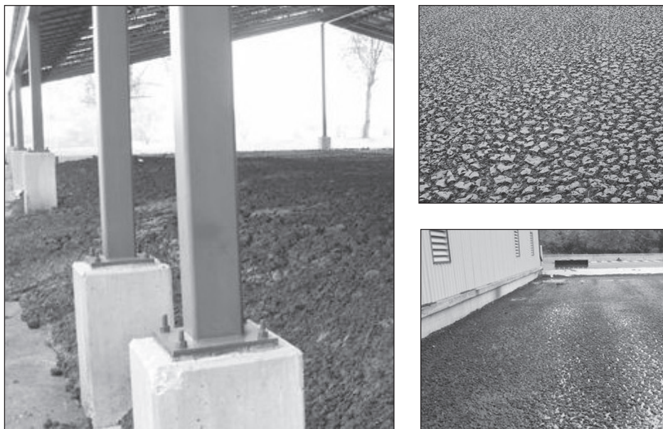
Figura 10.2 – Aie drenanti. Fango con il tipico aspetto di humus con superficie fratturata, dall'aspetto simile all'argilla secca.
