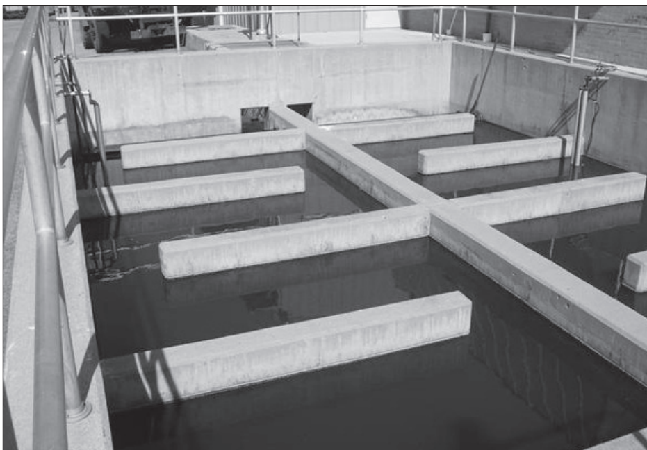
Figura 9.1 – Vasca di contatto a “serpentina” per la clorazione dell’effluente: reattore tipo “plug-flow”.
