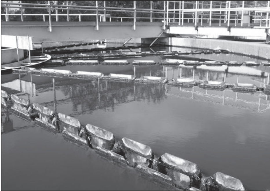
Figura 5.11 – Vasca di sedimentazione circolare con canalette a doppio stramazzo, disposte in senso radiale.
