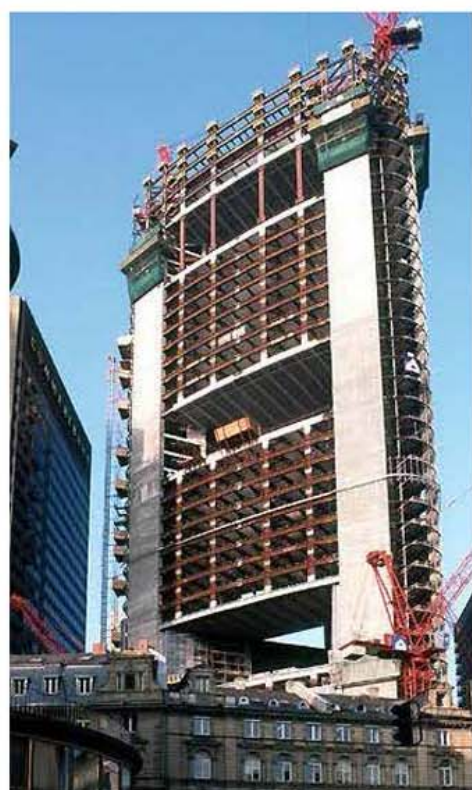
▲ Figura 10a Foto della struttura in costruzione al 42° piano dal piano stradale
